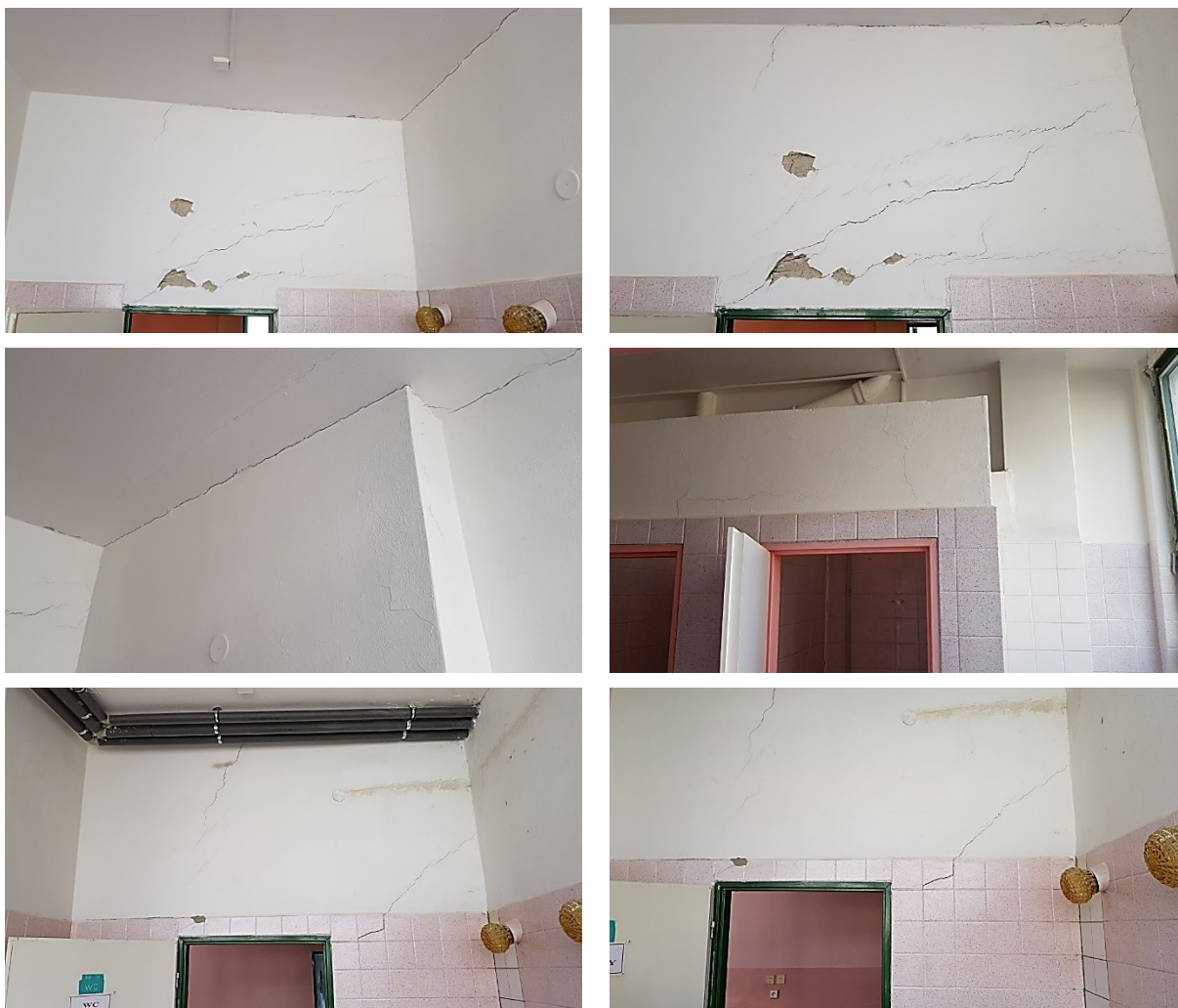
Obrázek 3, 4, 5, 6, 7, 8 – Pohled na trhliny v hygienických prostorách jihovýchodního křídla družiny při jihozápadní straně
